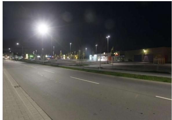
Abb. 4: Eine nicht nachhaltige Anwendung der DIN-EN 13201 führt zu Energie- und Ressourcenverschwendung: Bensheim, Fabrikstraße, 00:30 Uhr! Foto: J. Schneider
