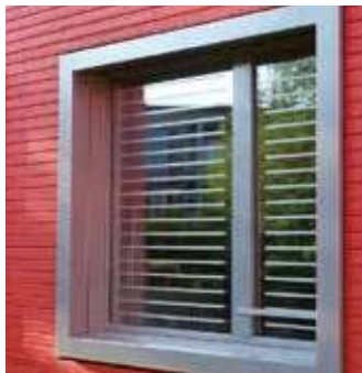
Für langlebige, dezente Aussenanwendungen: Oracal Kristallfolie ab Band. Bei horizontaler Montage beträgt der Abstand idealerweise 8cm.
